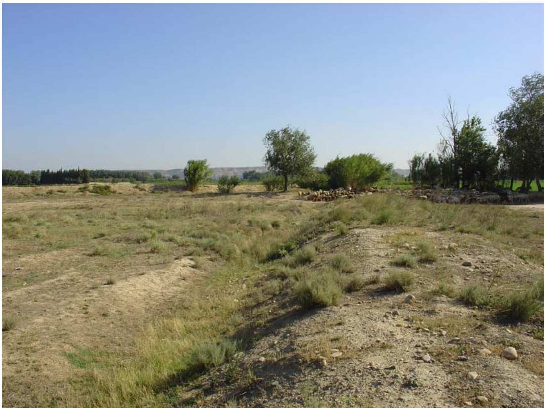
Mota de defensa de las avenidas fluviales en el área de transición entre la superficie agrícola y el ápice o extremo oeste del meandro sometido a inundaciones periódicas.
