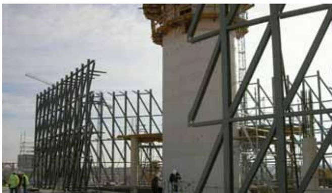
Fig. 8. Fases iniciales del montaje en obra de la estructura metálica de la fachada y las rampas.
